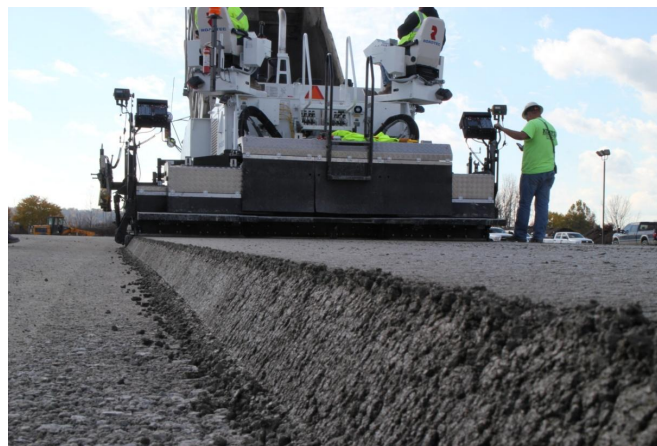
Рисунок 2 – Влаштування покриття з укочуваного наджорсткого цементобетону з формуванням кромки
