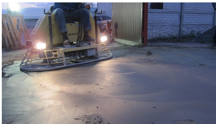
Рисунок 3 – Обробка покриття з укочуваного цементобетону затиральною машиною
